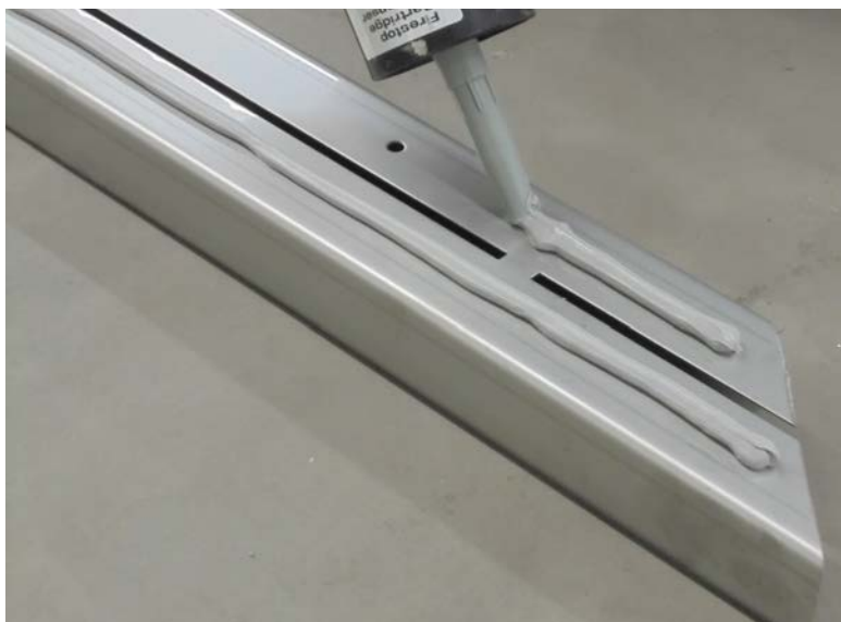
Unterseite des U-Profils mit Silikon versehen.
