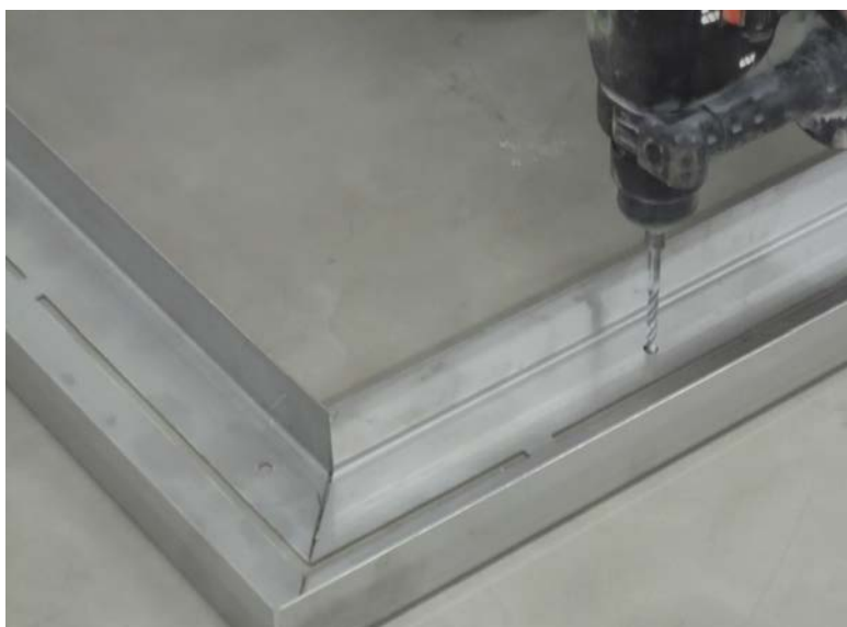
Profile am Boden festdübeln.
