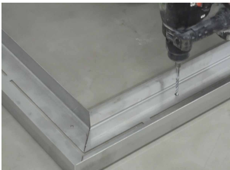
Profile am Boden festdübeln.
