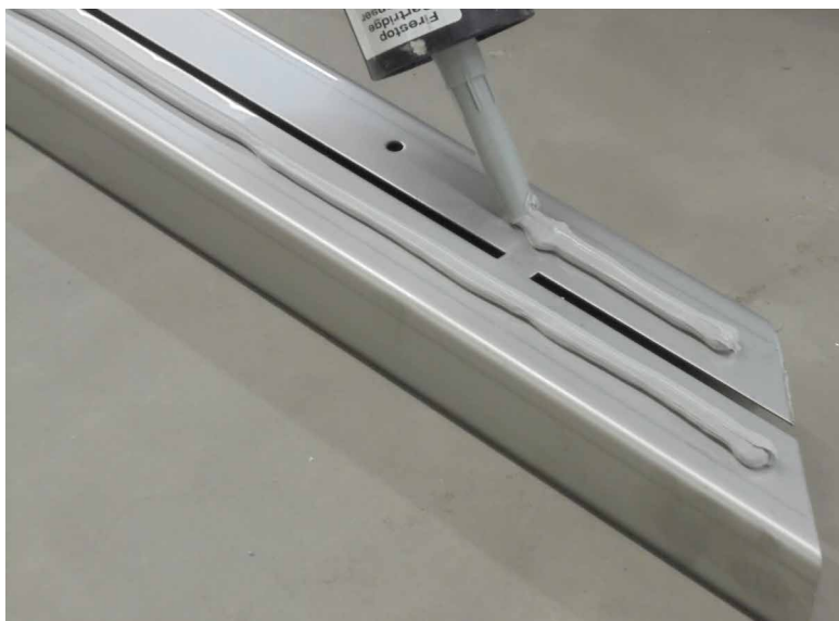
Unterseite des U-Profils mit Silikon versehen.
