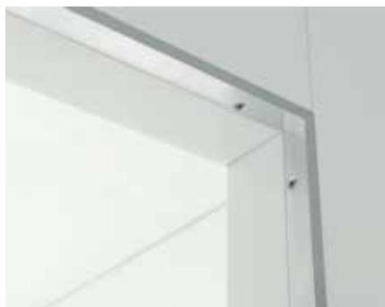
Die Türen der SBS Tiefkühlzellen sind standardmäßig mit einem Kälteunterbrecherprofil und einer Rahmenheizung ausgestattet.
