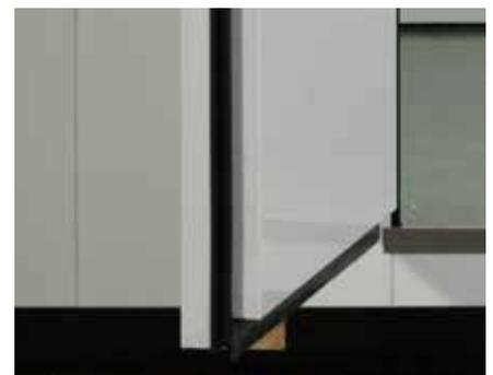
Die am Türblatt montierte Hohlkammerdichtung wird an der Blattunterseite durch eine Schleifdichtung ergänzt. Sie ist leicht zu reinigen und auszutauschen.
